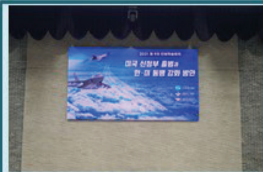
그랜드볼룸 최신 260인치 LED 설치
